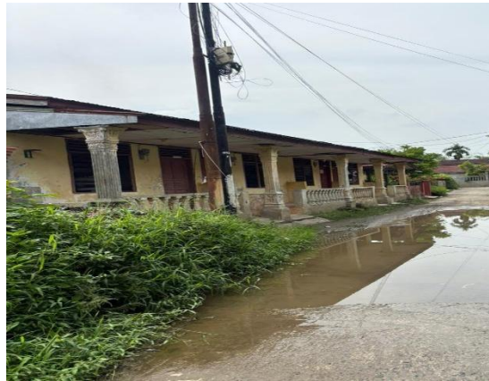
Gambar 3. Kondisi Genangan pada Jalur Evakuasi Menuju Titik Evakuasi
